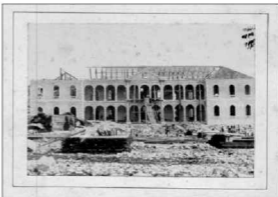
Branko Šobajić. Izgradnja dvorca u Nikšiću, oko 1899.
